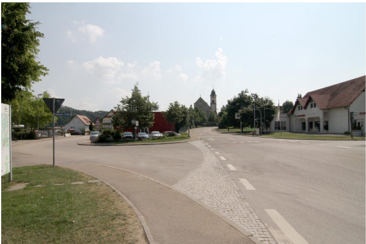
Unbefriedigende und unsichere Gestaltung Kreuzungsbereich Gaildorfer Straße / Hauptstraße / Hohenstadter Straße
