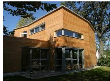
Ev. Kindergarten „Regenbogenhaus“ - Abtsgmünd
