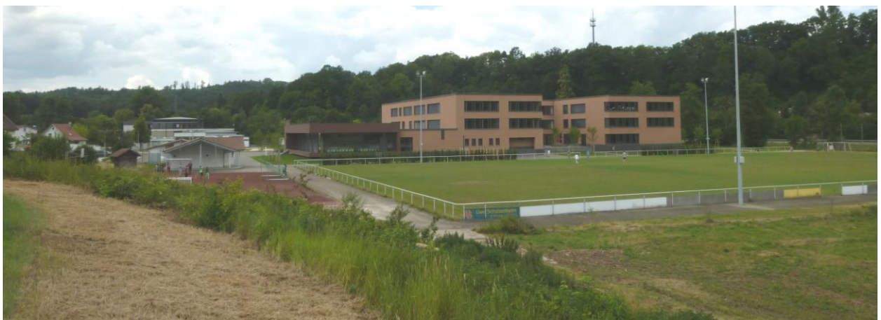
Untergenutztes Sport- und Freiflächenareal „Täferwiesen“
