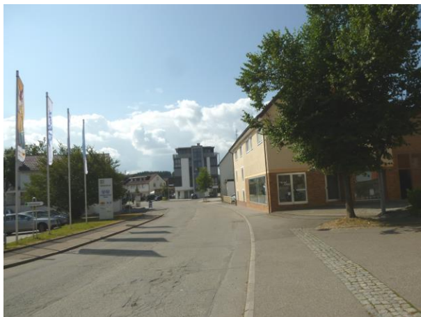
Straßenraum mit erheblichen Mängeln – Blickrichtung Süden
