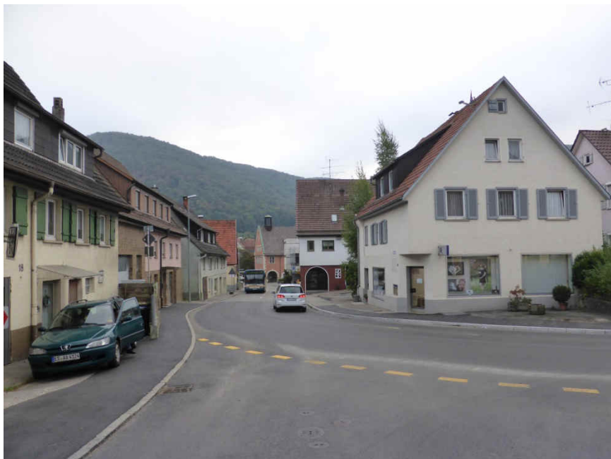
Blick Kurve Amtgasse / Adolf-Scheufelen-Straße B 465 Richtung Rathaus nach Südwest (Quelle Foto: FPZ)
