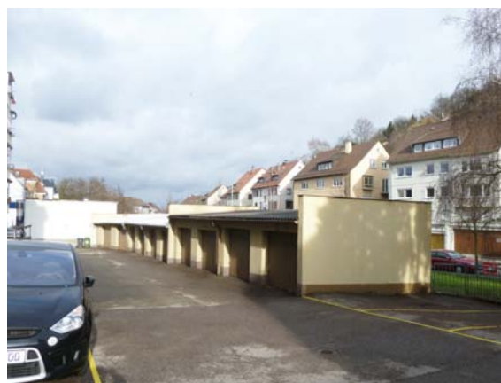
private Freiräume mit Mängeln in Zustand/Gestaltung
