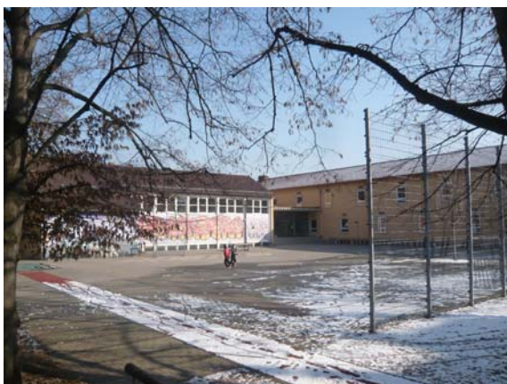
öffentliche Freiräume mit Mängeln in Zustand/Gestaltung Schulhof Grund- und Werkrealschule Gablenberg
