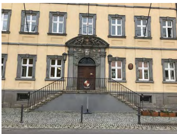
Treppenanlage zur Erschließung Rathaus – Foto FPZ
