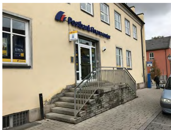
Treppenanlage zur Erschließung Post – Foto FPZ
